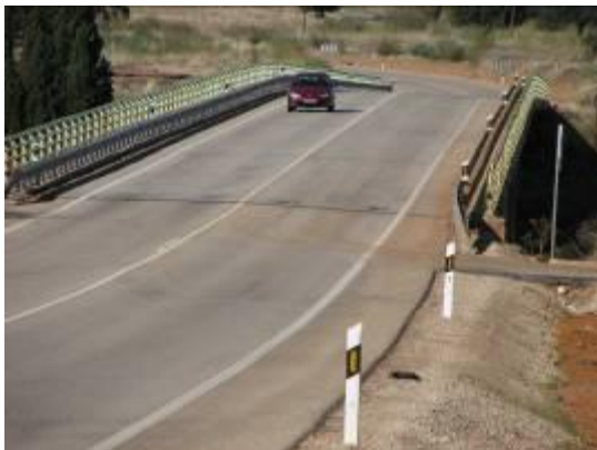
Foto. Vista de la vía de comunicación A-301 a su paso por el Area de Reintroducción
