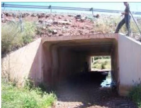
Figura 4.1 .Tipos de Pasos Naturales presentes en la vía de comunicación A-301: Paso Ganadero (Imagen Sup. izq.), Viaducto (Imagen Sup. Der.) y Canalización Arroyos mediante tubos de hormigón de 180 cm. de diámetro.
