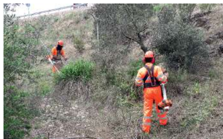
Figura 5: Acciones de desbroce de arceses.
