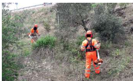
Figura 5: Limpeza de bermas das estradas.
