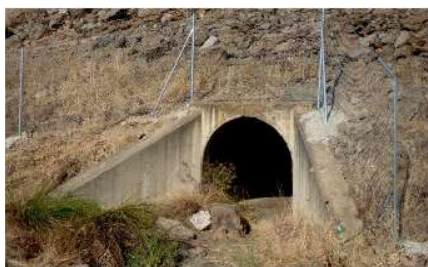
Figura 4: Trabalho de drenagem transversal adequado para o trânsito da vida selvagem.
