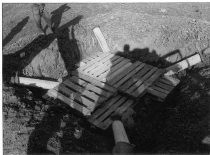
Figura 15-12. Construcción de un vivar tomando como base palets. En este caso, la estructura está colocada en profundidad, con tubos de cemento y cubierto por piedras del terreno.
