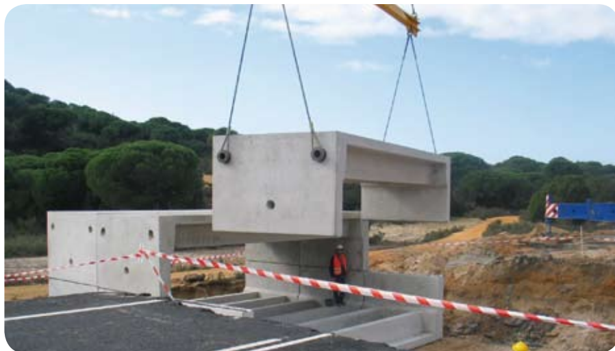
Construcción de un paso de fauna en Doñana. Foto: J. M. VIDAL.
