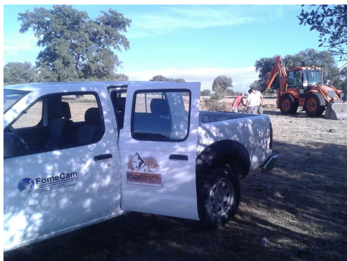
Obras de construcción del cercado de suelta blanda. Foto: LIFE+ Iberlince.
